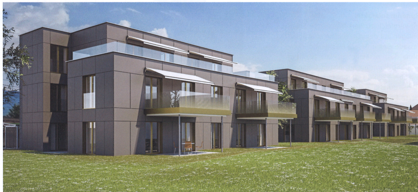
Die energierzeugende Gebäudehülle fällt auf. Hier wurden Solarmodule in Kombination mit einer vorgehängten hinterlüfteten Fassade verbaut.
